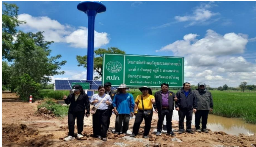
รูปภาพที่ 14 โครงการก่อสร้างหอดึงสูงและระบบกระจายน้ำเพื่อการเกษตรในเขต ปฏิรูปที่ดิน ครั้งที่ 1/2568 (ระยะที่ 2)
