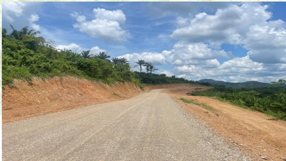
รูปภาพที่ 17 โครงการก่อสร้างถนนสายซอยในแปลงเกษตรกรรม ผิวจระจรหินคลุก ตำบลหงษ์เจริญ อำเภอลำทะเมนชัย จังหวัดชุมพร
