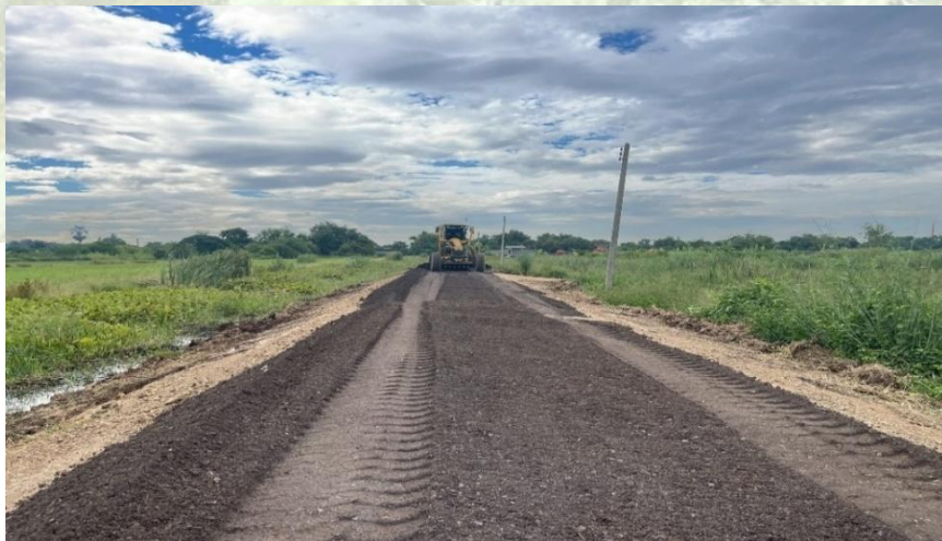
รูปภาพที่ 16 โครงการก่อสร้างถนนสายซอยในแปลงเกษตรกรรม ผิวจระจรหินคลุก จำนวน 6 สาย ตำบลวังน้อย อำเภอวังน้อย จังหวัดพระนครศรีอยุธยา
