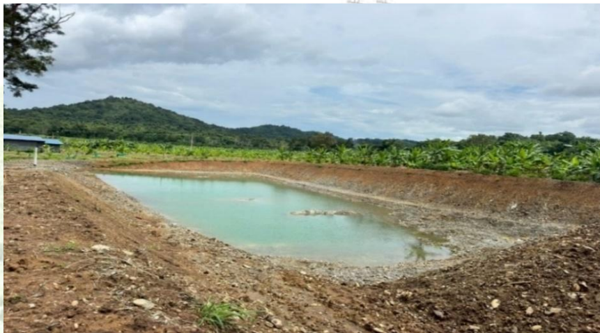
รูปภาพที่ 15 โครงการงานก่อสร้างสระเก็บน้ำสาธารณะ โครงการจัดที่ดินแปลงเกษตรเกื้อกูล ทับปะติโมเดล ตำบลโป่งน้ำร้อน อำเภอโป่งน้ำร้อน จังหวัดจันทบุรี
