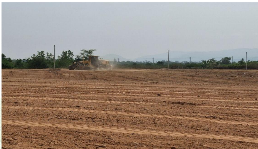
รูปภาพที่ 20 โครงการก่อสร้างถนนสายซอยผิวจราจรหินคลุกในแปลงเกษตรกรรม เกษตรกรสภาประชาชน 4 ภาค จังหวัดเพชรบุรี
