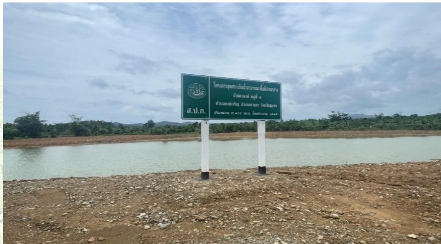
รูปภาพที่ 19 โครงการงานขุดสระเก็บน้ำสาธารณะ พื้นที่ส่วนกลาง แห่งที่ 2 ตำบลหงษ์เจริญ อำเภอบ้านหมี่ จังหวัดลพบุรี
